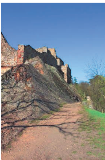
objekt - jižní cesta s opevněním PAMÁTKOVÁ OCHRANA: kulturní památka rejst. č. ÚSKP 37166/2-409, stav ochrany: památkově chráněno NA PLOŠE: ochranné pásmo KATALOGOVÉ ČÍSLO: 1000149071_0009 Cesta vysekaná ve skále podél jižní hradby, z jižní strany místy lemovaná kamennou zídkou. Vznikla při renesančních úpravách v souvislosti s přemístěním hlavní brány do jihozápadního cípu hradu.
