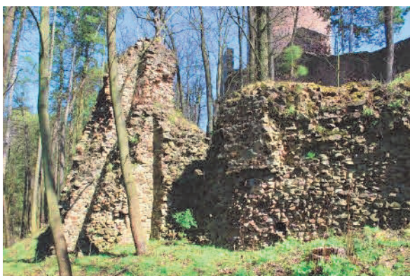
objekt - severní hradba PAMÁTKOVÁ OCHRANA: kulturní památka rejst. č. ÚSKP 21737/2-408, stav ochrany: památkově chráněno národní kulturní památka rejst. č. ÚSKP 239, stav ochrany: památkově chráněno NA PLOŠE: ochranné pásmo KATALOGOVÉ ČÍSLO: 1000132648_0006 Relikty vnější hradební zdi, vymežující severní předhradí.
