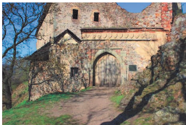
objekt - jihozápadní brána PAMÁTKOVÁ OCHRANA: kulturní památka rejst. č. ÚSKP 37166/2-409, stav ochrany: památkově chráněno národní kulturní památka rejst. č. ÚSKP 239, stav ochrany: památkově chráněno NA PLOŠE: ochranné pásmo KATALOGOVÉ ČÍSLO: 1000149071_0303 Brána otevřená jedním lomeným obloukem s okosením, vybudovaná při renesanční přestavbě jako nový vstup do hradu. Horní část je zdobená heraldickým vlysem, přeneseným sem ze zaniklé severovýchodní brány.
