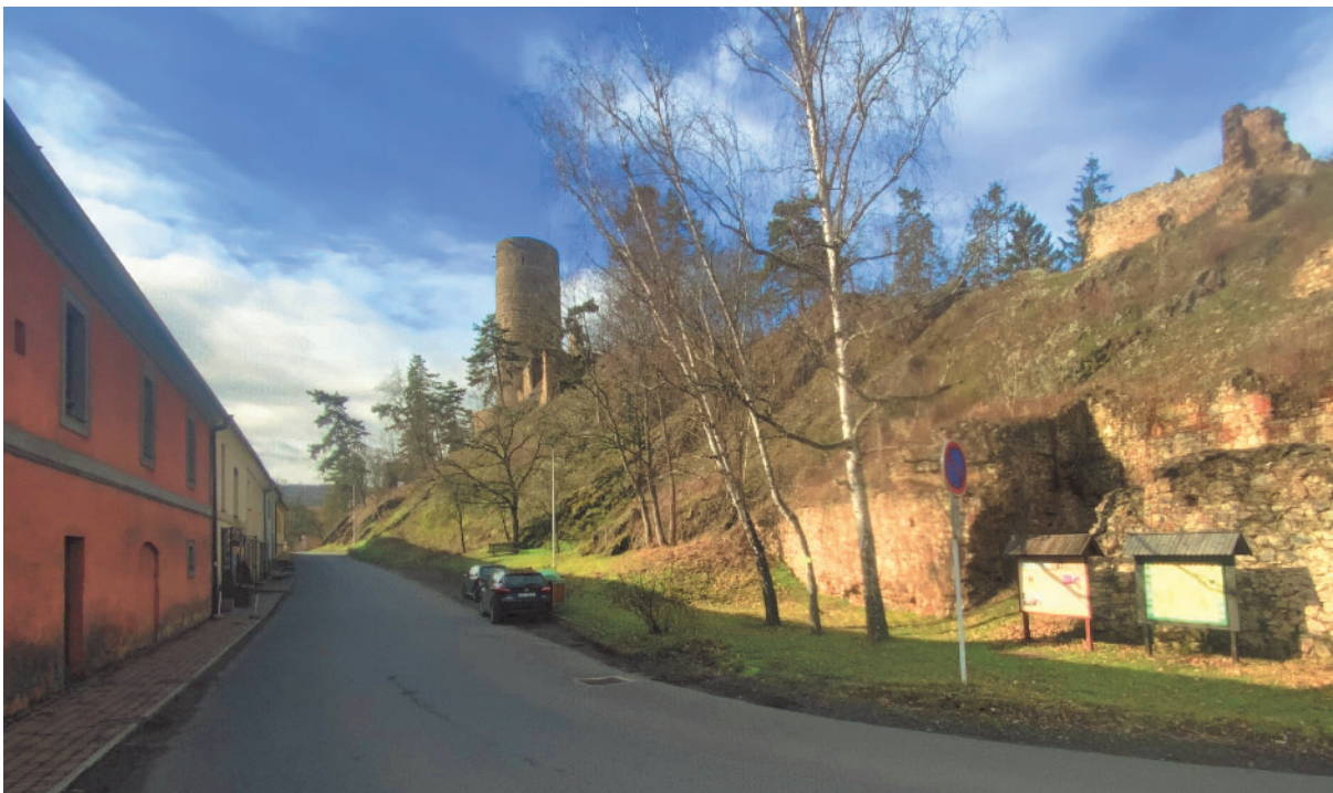
Foto: památkově chráněné domy bývalého purkrabství situované proti hradnímu masivu s pozůstatky hradu Žebrák
